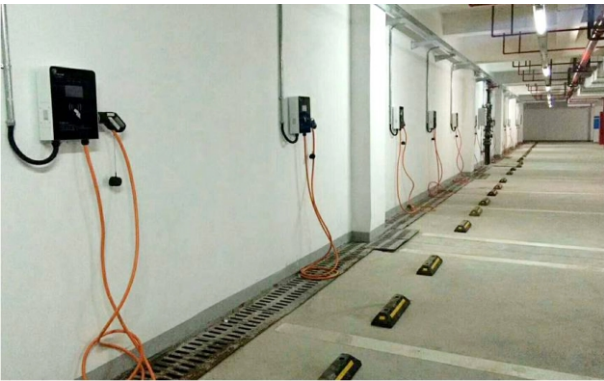
上海万达广场项目使用公司研发生产100多台7kw单枪壁挂交流桩
