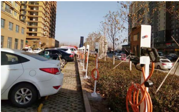
某充电桩运营公司采购与使用我司200多台研发生产7kw单枪交流桩
